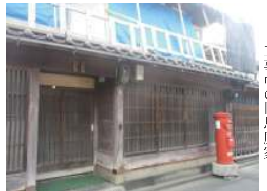
工事中の旧馬庭家
