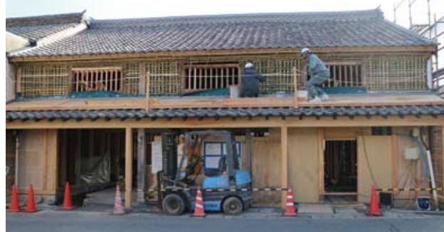
正面足場が取り払われました
